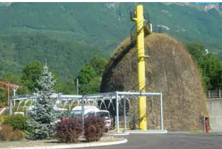
Stockage Totalgaz à Frontenex (73)
