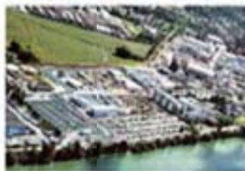
Installation classée Seveso à Conay. Photo: Françoise Noiret
